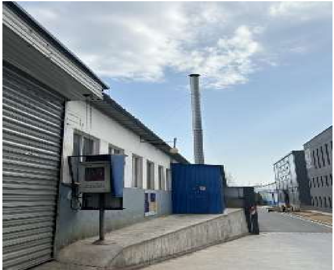
图 3-5 喷漆工序 15 米排气筒
