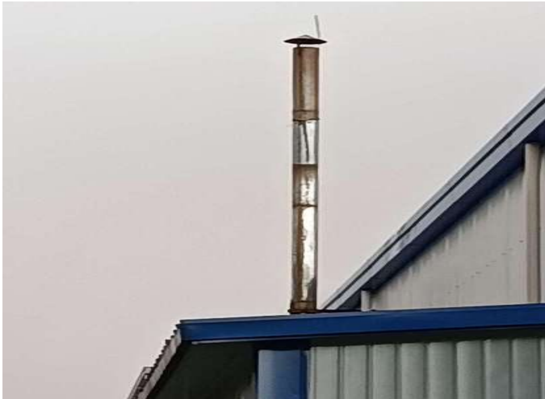
图 3-6 正火、回火、淬火工序排气筒
