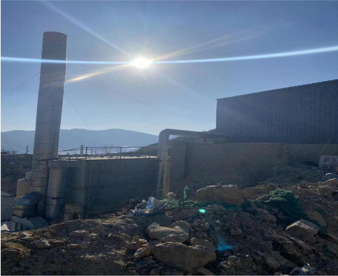
图 3.2-4 破碎筛分布袋除尘器及排气筒（1）
